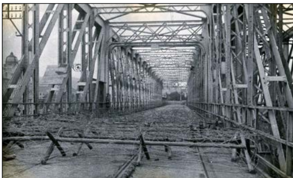
Všechny mosty byly zatarasené proti Maďarům, 1919
